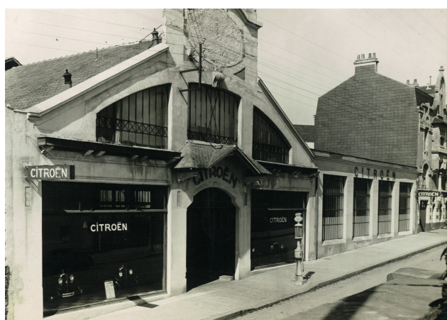
Façade de la concession Citroën de Cholet Photo : M. Richard
