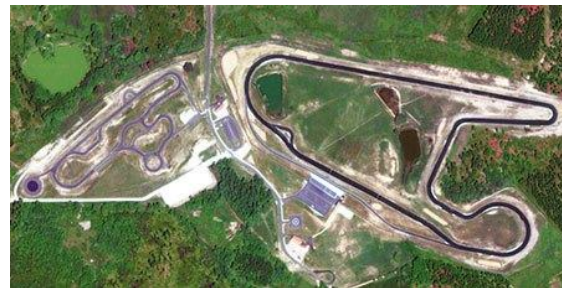
Un circuit signé JPB avec de belles installations
